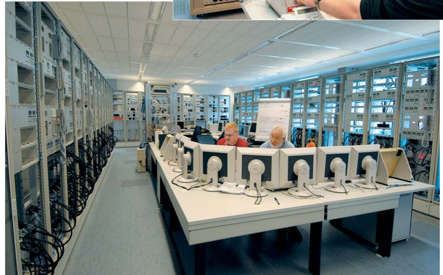
Das Labor, in dem „CIDAS“ getestet wird, das „Nervensystem“ der A380-Kabine. Bild oben: Der Touchscreen für die Kabinenbeleuchtung, so wie er auch im fertigen Flugzeug installiert sein wird
