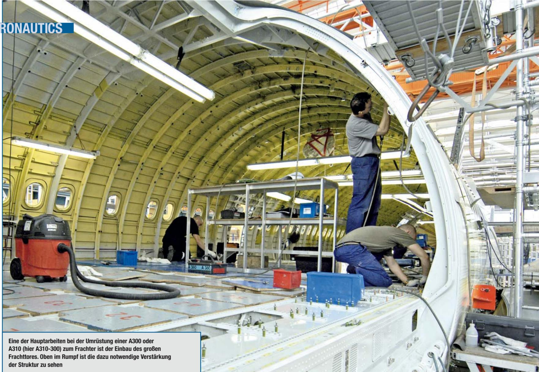
Eine der Hauptarbeiten bei der Umrüstung einer A300 oder A310 (hier A310-300) zum Frachter ist der Einbau des großen Frachttores. Oben im Rumpf ist die dazu notwendige Verstärkung der Struktur zu sehen
